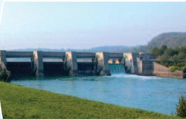
Sur cette portion, le cours du fleuve est très plat. Avec une retenue de 28 kilomètres, la hauteur de chute maximale n'est que de 9,7 m.
